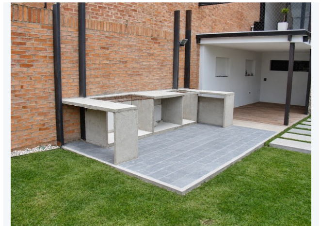
Fotografía del proceso de ejecución.
