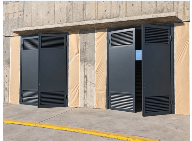
Accesos a recintos técnicos.
