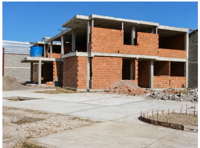
Avance de los cerramientos de albañilería.
