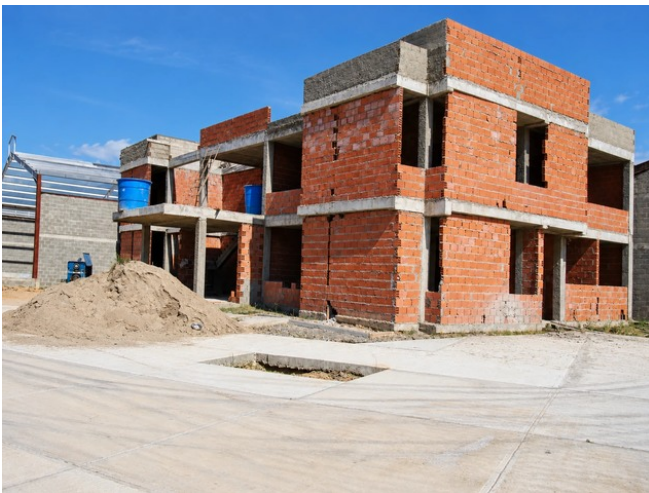
Vista general del edificio en ejecución.
