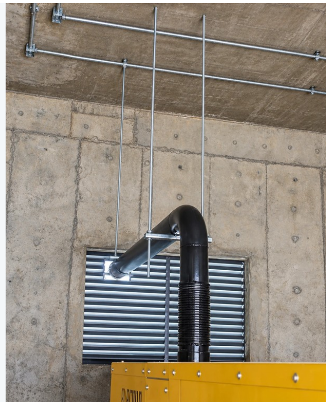
Recorrido del conducto y sistema de soportación.
