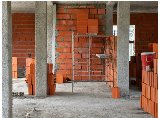
Tabiquería y encuentros con la estructura.
